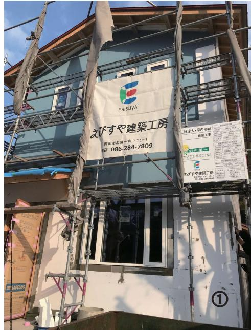
先月のドーモでも、触れたように、外壁の断熱工事をしています。写真①で水色に見えるのが、防水と、気密を取るための防水塗料です。ここで、雨水の侵入を完全にシャットアウトします。この上に、白く見えるEPS(ビーズ法ポリスチレンフォーム)と呼ばれる断熱材(厚さ50mm)を、貼りつけます。貼りつけた後、包帯の親玉のようなメッシュシートと呼ばれるシートでそれを覆い、樹脂モルタルで塗り込んでいきます。この上からさらに、仕上げ材を塗り、外壁の完成です。メッシュシートで巻き固めていますので、外壁のひび割れとかがしにくくなり、きれいな状態を長く保つことができます。
