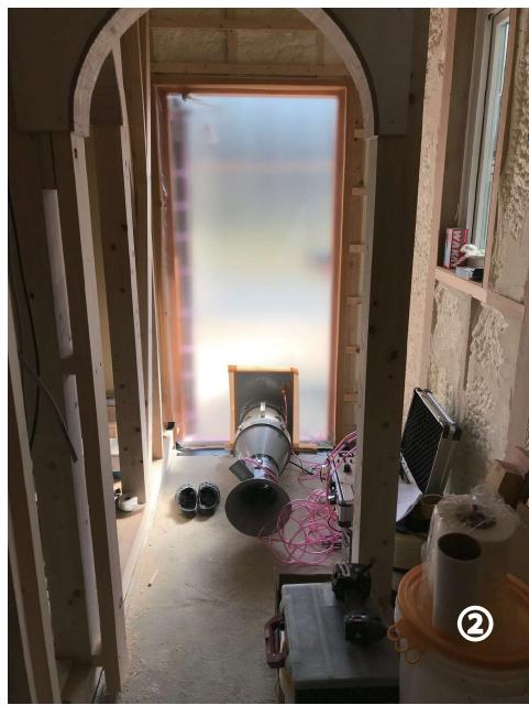
また、写真②の中央に見えるラッパのような機械は、建物の気密を測るために機械です。ドアとか窓などの開口部を閉じた状態でどれだけの隙間がこの家にあるのかを測ります。建物の気密の度合いを表す数値をC値(相当隙間面積)といい、建物全体の隙間面積を、床下を含めた実質床面積で割算した数値( $\text{cm}^3/\text{m}^2$ )で表わします。国の基準ではその値が $2\text{cm}^3/\text{m}^2$ 以下であれば高気密住宅であるとしていますが、実際はそれでは、不十分で、C値が0.3から0.7くらいに収まることが望ましいと言われています。では、こちらの建物のC値はといえば、
