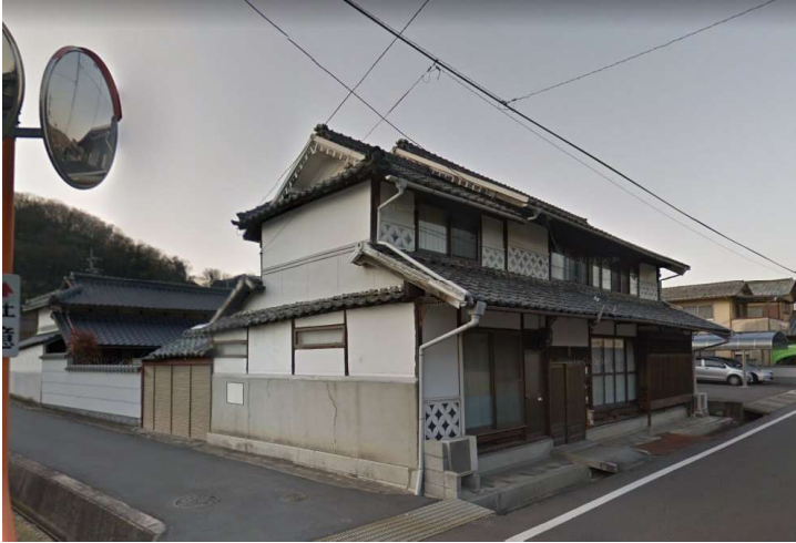
既存建物解体前
