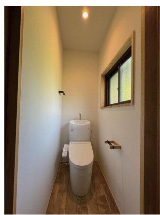
トイレ改修後
