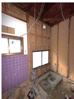
浴室・洗面室解体後
