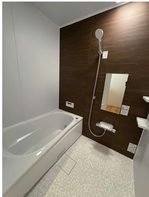
工事完了後 以前あった窓は撤去して壁にしています。
