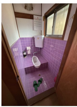
トイレ改修前
