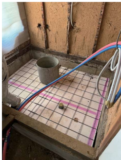
土間コンクリートの下側に10cm厚の断熱材を敷き込んでいます。
