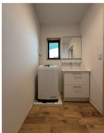
洗面室改修後
