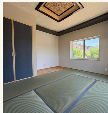
折上げ天井を活かした和室
