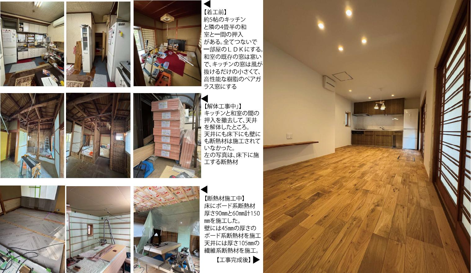
暖かい部屋にしたいというのがお施主様のご要望でした。それと、キッチンと和室の2部屋を一部屋にして広々と使いたいというのが2つ目のご要望。幸いにも押入の柱は構造には関係していないので、撤去しても問題はなかったので、解体をして合計で12畳弱のLDKができました。断熱は、天井に厚さ105ミリの高性能ロックウールを2段重ねして敷き込みました。壁には塞いだ窓のところに同じく厚さ105ミリの高性能ロックウールと、外に面した壁全体に45ミリのボード系の断熱材を貼り付け合計150ミリの厚さの断熱層を、床には、厚さ90ミリと60ミリのボード系断熱材を交差して敷き詰め合計150ミリの厚さの断熱層を作りました。
